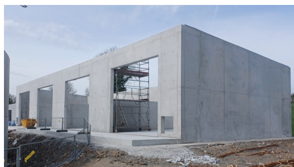
Hangar de stockage (avril 2023)
